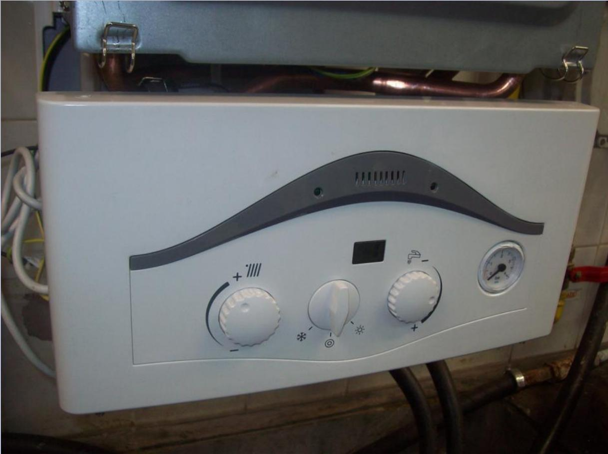
Perilla encendido, Calefacción y ACS (Invierno) o sólo ACS (Verano. Dos perillas regulación de temperatura, una para Calefacción y otra para ACS.
