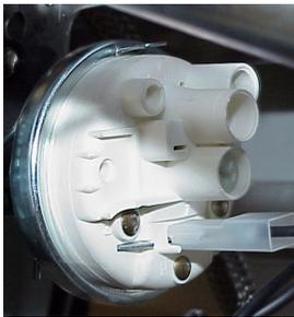
Integrado en el grupo hidráulico, controla la presión del circuito de calefacción.
