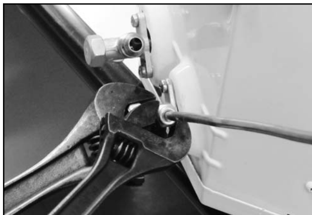
FIGURA 31 - FIJACIÓN DE LA TUERCA
